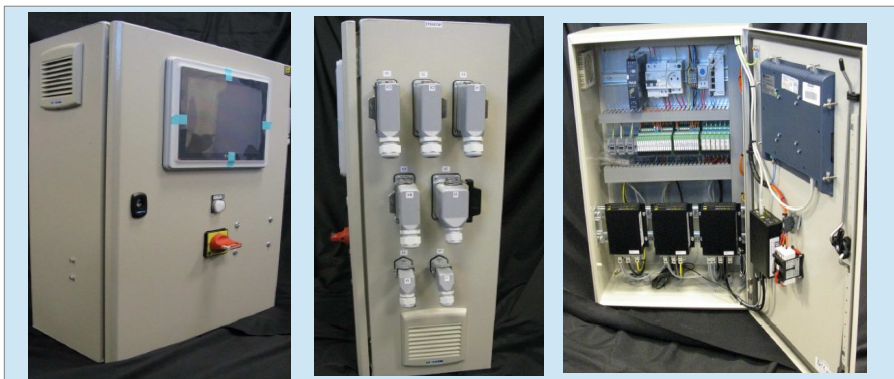
Le coffret de télégestion (exemple avec 3 pompes en station)
