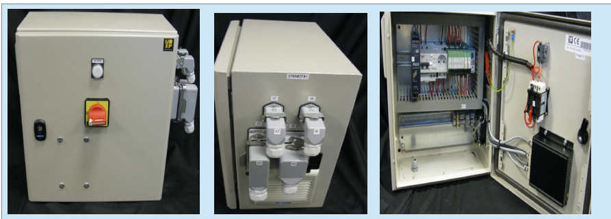
Le coffret de forage à connecter à l'armoire électrique existante
